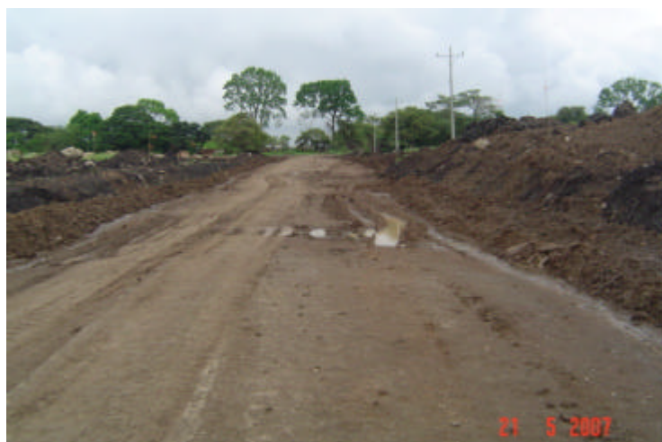
Foto # 11 Zona de sustitución con vista hacia la entrada de la calle pública. En el fondo se aprecia la zona estabilizada.
