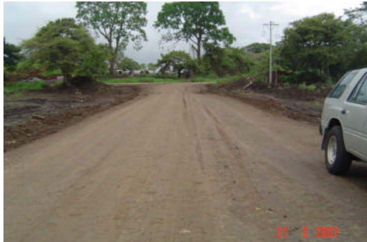
Foto # 9 Zona Estabilizada con vista hacia la calle pública.
