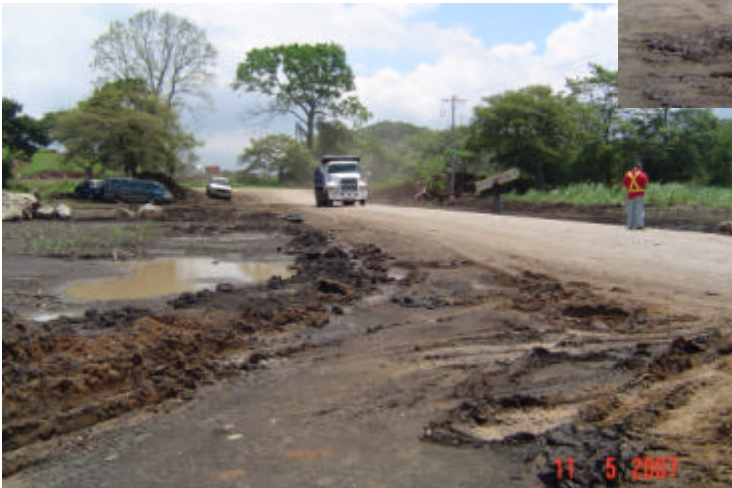
Foto # 5 y 6 Vista de la zona estabilizada luego de la compactación y colocación de una capa pequeña (30 cms aprox.) de material de préstamo para cubrir la arcilla estabilizada
