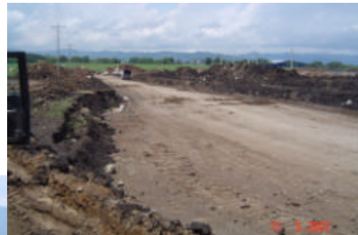
Foto # 7 y 8 Zona con sustitución. Luego de sacar la arcilla expansiva le colocaron una capa similar a la que pusieron sobre la zona estabilizada.
