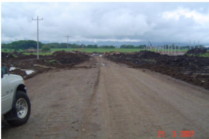
Foto # 10 Zona Estabilizada con vista hacia la zona de sustitución. Se puede notar donde termina la zona estabilizada y comienza la sustitución.
