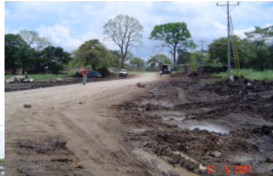
Foto # 5 y 6 Vista de la zona estabilizada luego de la compactación y colocación de una capa pequeña (30 cms aprox.) de material de préstamo para cubrir la arcilla estabilizada
